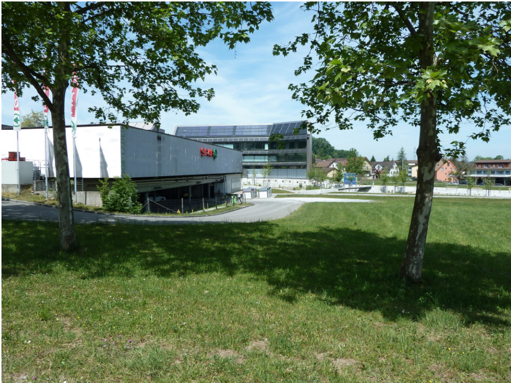
Die bestehende Tiefgarage mit dem darüberliegenden Ladenprovisorium
