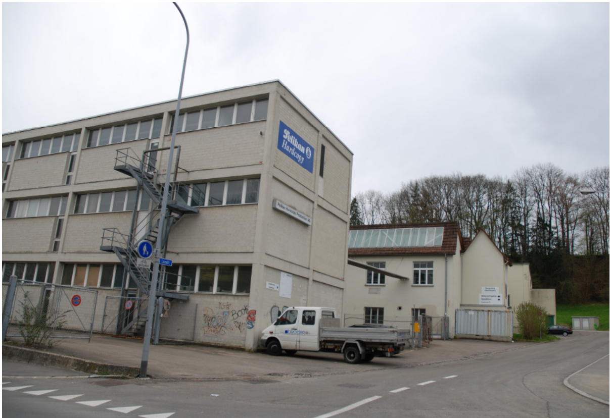
Bau 2 mit dahinterliegendem „Altbau“
