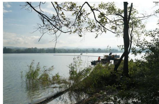
Einwassern der Seeleitung, Seite Maur, Oktober 2018
