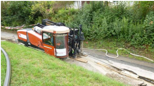
Spülbohrung Unterquerung Chalenbach, Engelstrasse, September 2018
