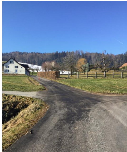
Sanierte Bergstrasse nach dem ersten Winter, Blick Richtung Bollerrain, Februar 2019
