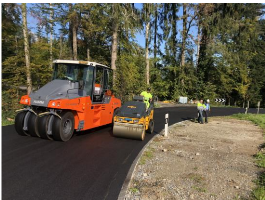
Verdichtungsvorgang Tragdeckschicht, Kurve Militärweg, Oktober 2018
