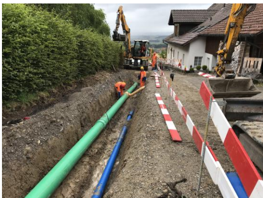
Neu verlegte Wasserleitung und eingedolter Bollerrainbach, Bollerrain, Juli 2018
