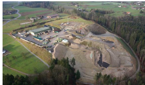
Luftbild der Deponie Chrüzlen vom 6. Januar 2018 (Wiedag Recycling und Deponie AG)
