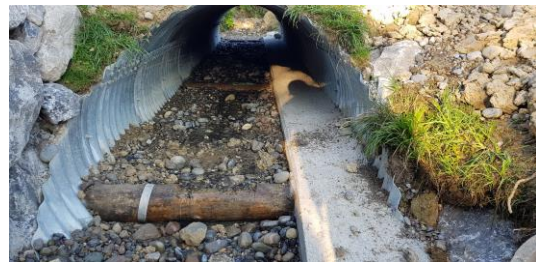
Durchlass mit terrestrischer Längsvernetzung (Bankett) aus Ortsbeton und Schwellenhölzer, September 2018
