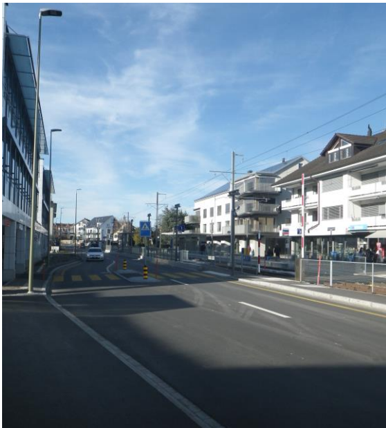
Sanierte Strasse mit behindertengerechter Haltestelle Egg
