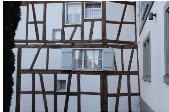
Riegelfassade in Hinteregg
