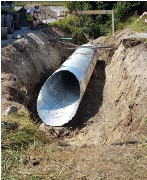
Einbau Durchlass Wellstahlrohr \varnothing 1320 \times 1480 \text{ mm} , Vollikerbach, August 2018
