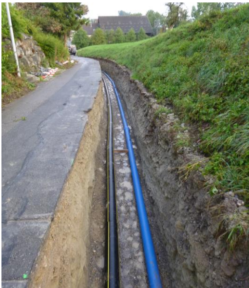
Wasser- und Gasleitung, Engelstrasse, September 2018
