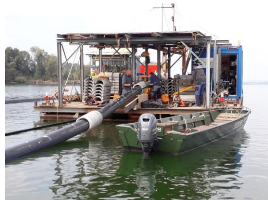
Ballastieren der Seeleitung auf einer mobilen Arbeitsplattform, Oktober 2018
