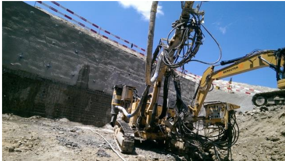
Baugrubensicherung Reservoir Esslingen
