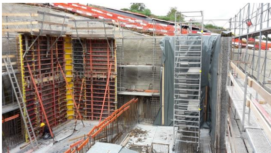
Schalungsarbeiten Reservoirkammern
