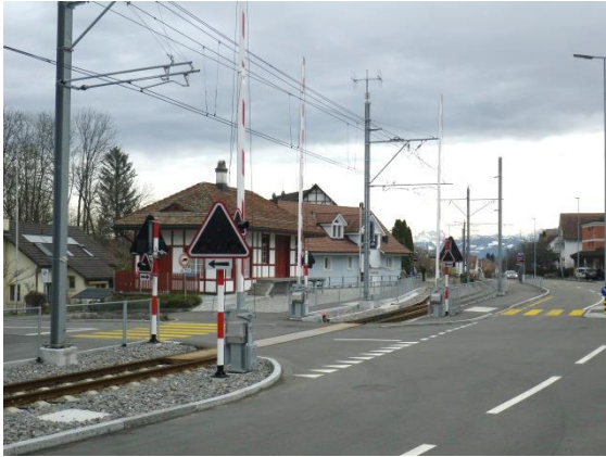
Bahnübergang Güetlistrasse nach Fertigstellung
