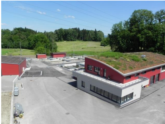
Bauvollendung ARA Esslingen
