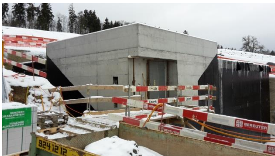
Rohbauvollendung Ansicht Schieberhaus
