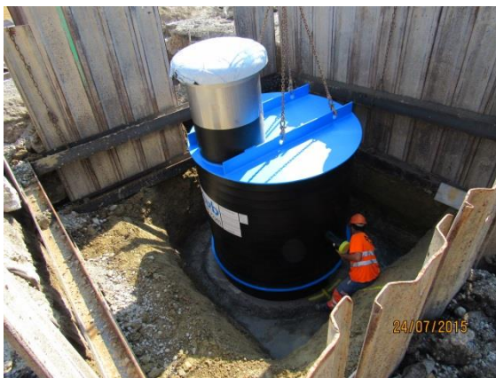
Einbau Druckreduzierschacht Unter Halden
