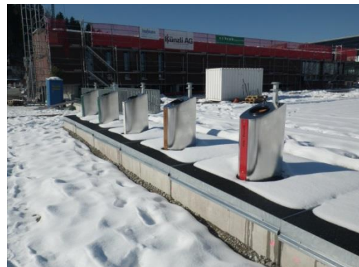
Neue Unterflursammelstelle in Esslingen kurz vor Fertigstellung
