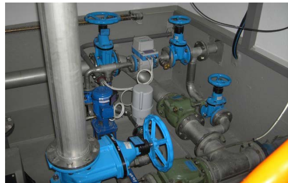
Rohrkeller Reservoir Hochwacht
