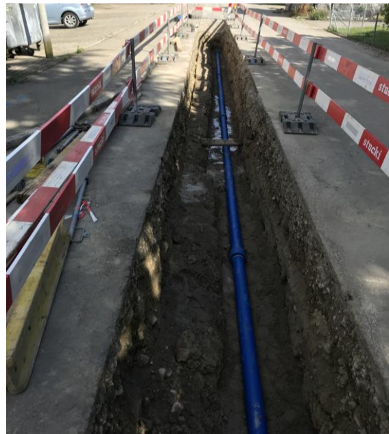
Neue Wasser-Versorgungsleitung, Im grünen Hof, August 2019
