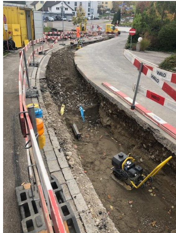
Leitungsgraben Felseneggstrasse, Oktober 2019
