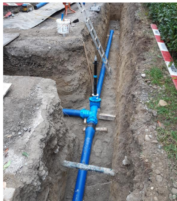
Einbau Streckenschieber T-Stück, November 2019
