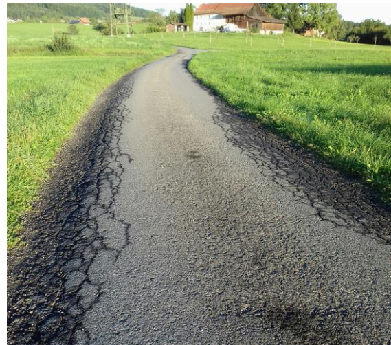
Zustand Hostigstrasse vor der Sanierung, September 2017
