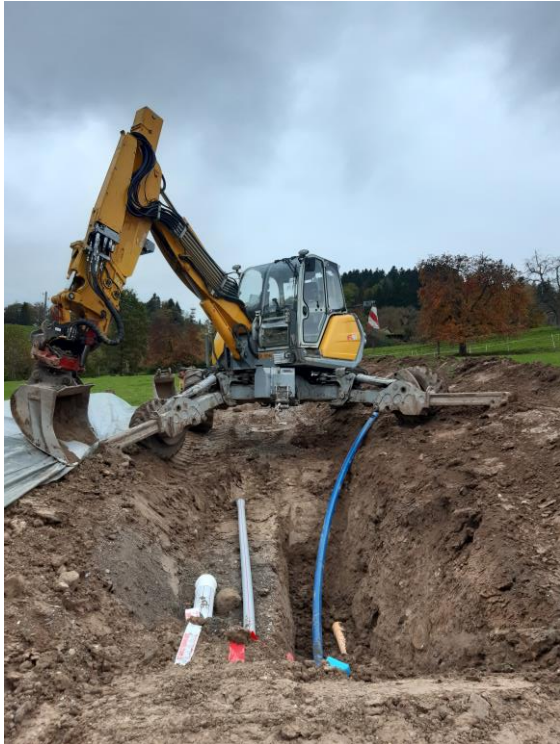
Neu verlegte Rohrleitungen - Spezialarbeit mit Menzi Muck, Oktober 2019
