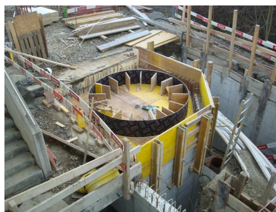
Schalungsarbeiten Decke Dosierkeller
