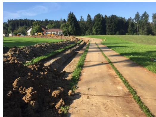
Transportpiste aus grossflächigen Stahlplatten, August 2019
