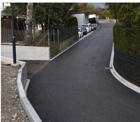
Rietwisstrasse nach der Sanierung im Februar 2020
