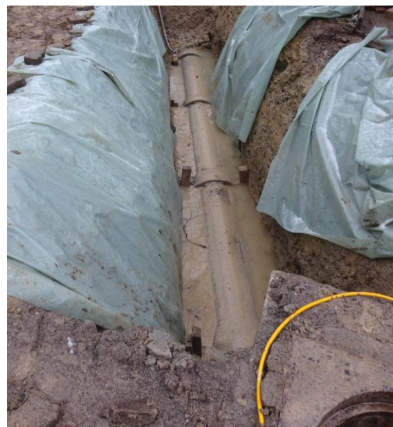
Neu verlegter Kanalabschnitt In den Seewiesen, Februar 2019
