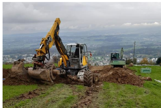
Baggerarbeiten unterhalb Schaubigen, Oktober 2019
