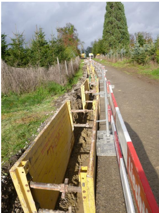
Leitungsgraben entlang Stegstrasse, Tannacher, November 2019
