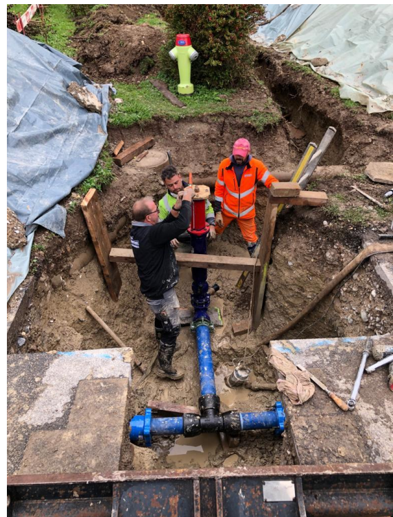
Einbau Hydranten-Unterteil an der Alten Zürichstrasse, Tannacher, Oktober 2019
