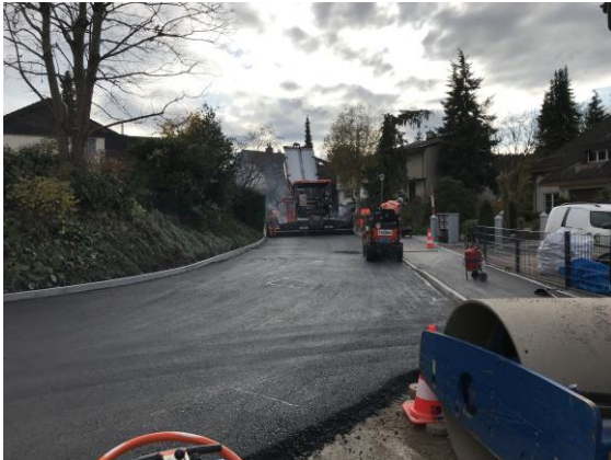
Einbau der Asphalttragschicht 1. Etappe, Im grünen Hof, November 2019
