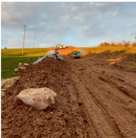
Verdichtungsvorgang im Grabenbereich, Hanglage oberhalb Pfannenstielstrasse, Oktober 2019
