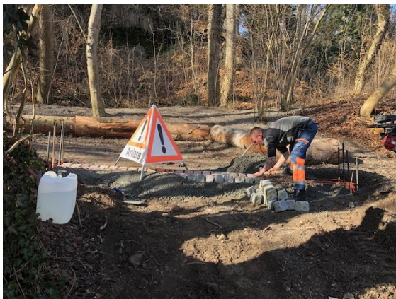
Werkhofmitarbeiter beim Versetzen einer Querrinne, Sanierung Fussweg Lee - Schürwies, Februar 2019
