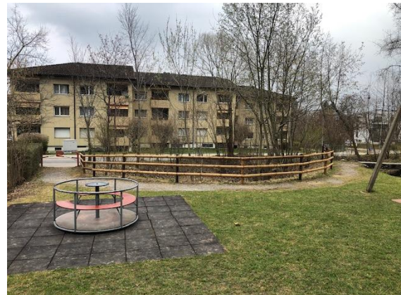
Durch das Werkhofteam neu erstellter Halbrundlattenzaun beim Retentionsbecken, Spielplatz Bützi, März 2019
