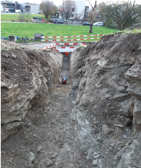
Leitungsgraben im Fels, Ringschluss-Ersatz, November 2019
