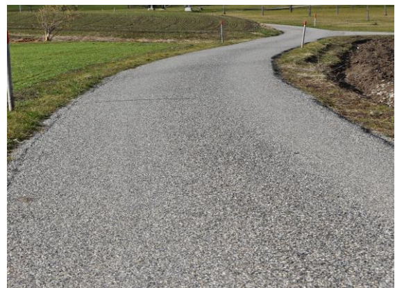
Zustand Hostigstrasse nach Oberflächenbehandlung mit Splittabstreuung, Februar 2020
