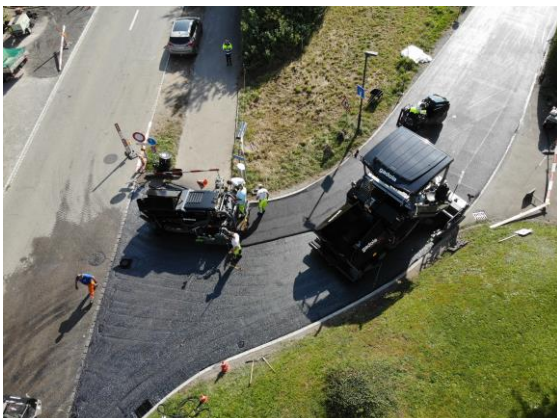
Luftaufnahme vom Belagseinbau, September 2020
