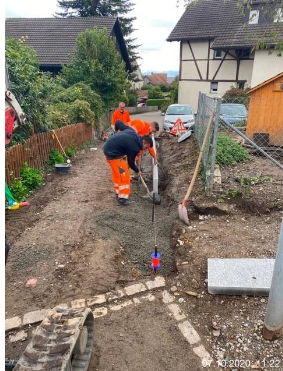
Sanierung Gehweg Im Leeacher durch die Mitarbeiter des Werkhofs, Oktober 2020
