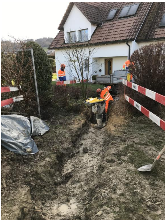
Erneuerung einer Hauszuleitung, Februar 2020
