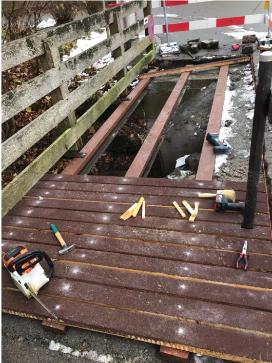
Brückensanierung am Hofnerbach, Steg-Glärnischstrasse, Dezember 2020
