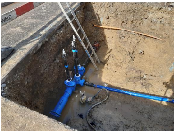
Ersatz des Combi-3 Flanschenschiebers in der Büelstrasse, März 2020
