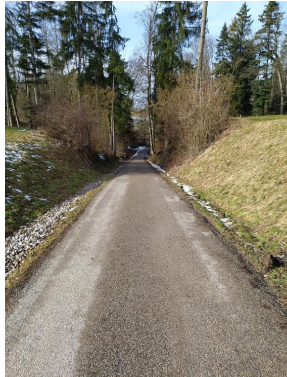
Zustand Alte Zürichstrasse in Blickrichtung Aspholz nach Oberflächenbehandlung mit Splittabstreuung
