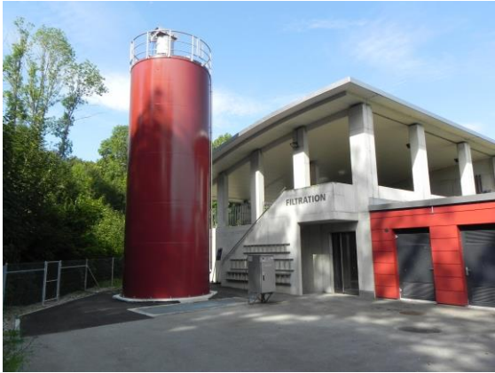
Silo zur Lagerung der Pulveraktivkohle (PAK), August 2020
