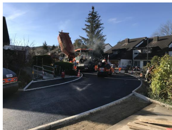
Einbau der Asphalttragschicht 2. Etappe, Im grünen Hof, November 2020
