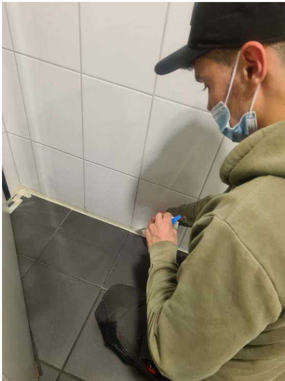
Erneuerung der Kittfugen in den WC-Anlagen des Gemeindehauses, November 2020
