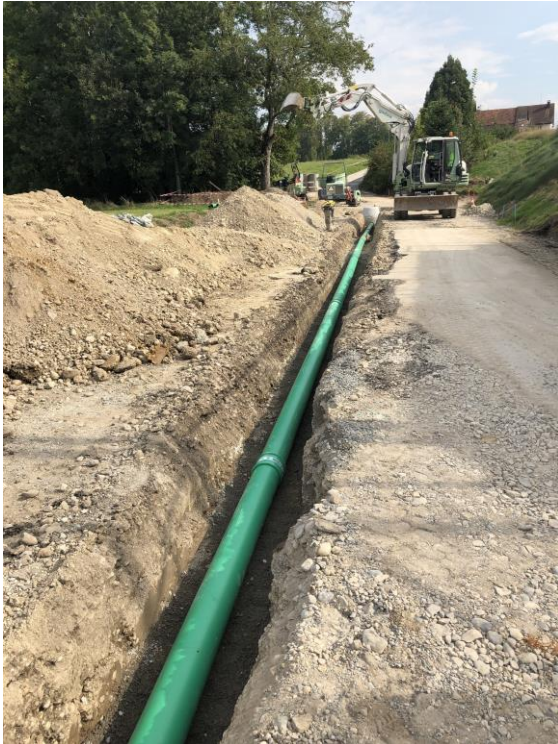
Neue Ableitung für die Strassenentwässerung, Tüftelstrasse, September 2020
