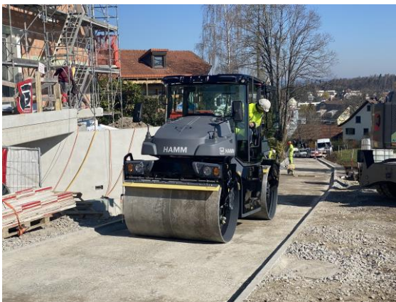
Verdichtungsvorgang des neuen Kieskoffers an der Ebnetstrasse, April 2020
