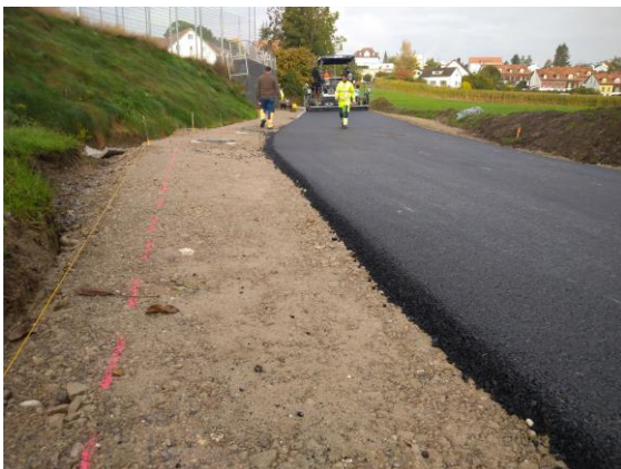
Belageinbau Tüftelstrasse - Kirchwiesweg, Oktober 2020
