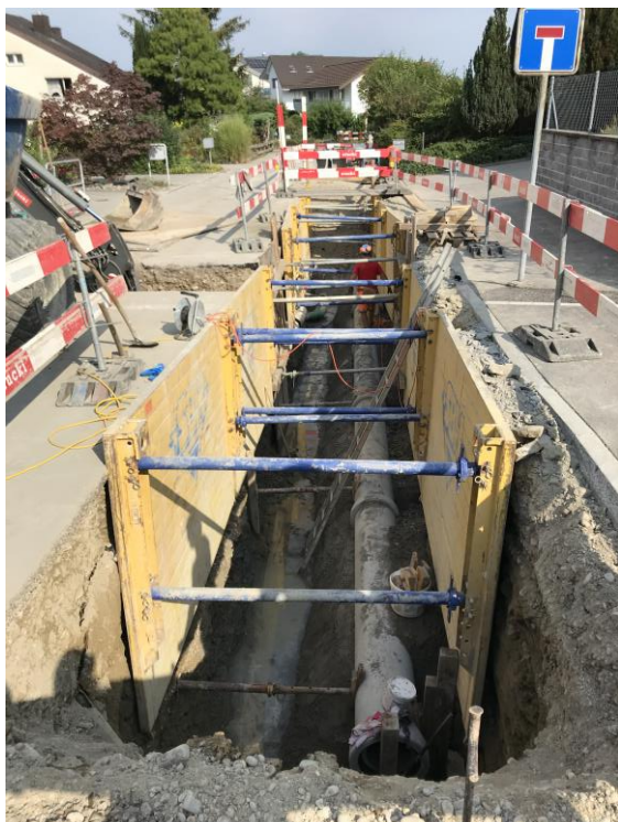
Ersatzneubau Kanal, September 2020
