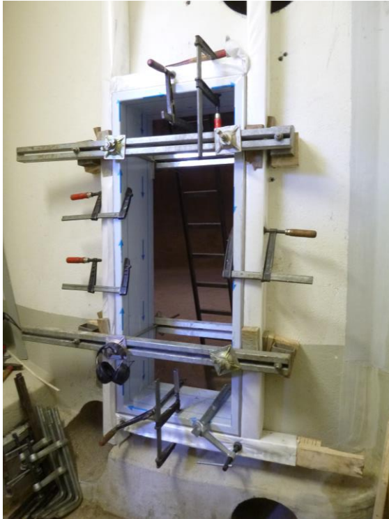
Montage Türzargen für die neuen Drücktüren im Reservoir Pfannenstiel (alt), Dezember 2020
