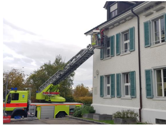
Mit Hilfe der Feuerwehr-Drehleiter wurden die künstlichen Nisthilfen montiert. Hier am Schulhaus Hinteregg.
