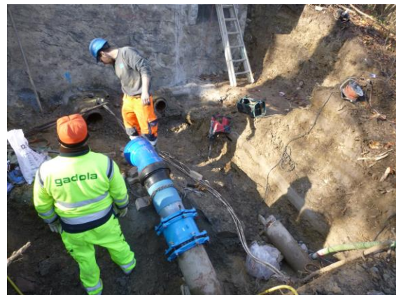
Neubau Reservoirableitungen, Reservoir Pfannenstiel (alt), November 2020
