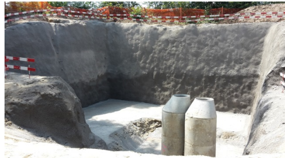
Baugrubensicherung Reservoir Büelholz, August 2016
