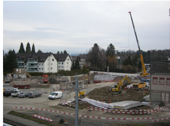
Baustelle im Gestaltungsplangebiet Rietwis-West
