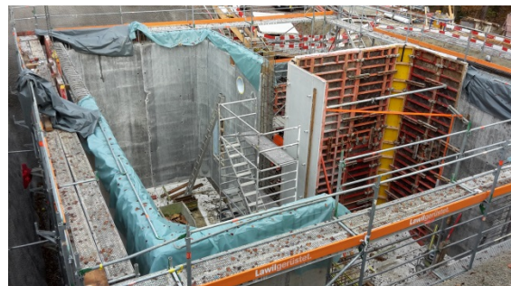
Schalungsarbeiten Reservoirkammern, November 2016
