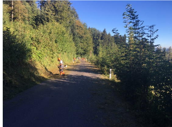
Böschungspflege Pfannenstielstrasse, August 2016
