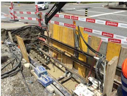
Querung Neue Meilenerstrasse im Pressbohrverfahren, Mai 2016
