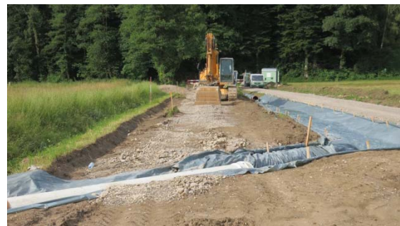
Erstellung neues Gerinne mit provisorischer Wasserhaltung, Juni 2016
