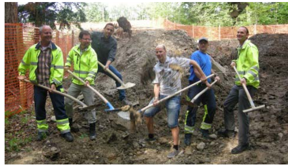
Spatenstich Reservoir Büelholz, Juni 2016
