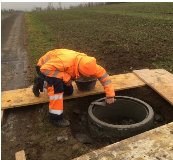
Reparaturarbeiten an einem Entwässerungsschacht
