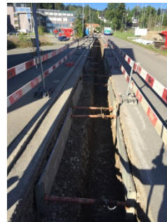
Leitungsbau Löwenstrasse, September 2016
