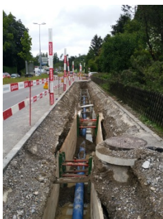
Rohrleitungsbau entlang Rällikerstrasse, Juni 2016
