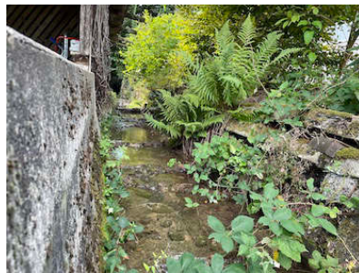
Abschnitt Leu_07; einseitige Mauer, einseitige künstliche Uferverbauung mit Holz, keine Breitenvariabilität (rund 15 m des Abschnittes)
