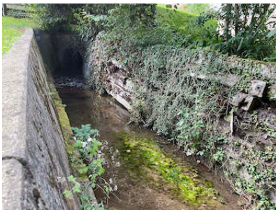
Abschnitt Leu_07 vor Dole Leeacherstrasse; einseitige Mauer, einseitige künstliche Uferverbauung mit Holz, keine Breitenvariabilität, bestehende Gerinnesohlenbreite leicht breiter als beim restlichen Abschnitt (rund 10 m des Abschnittes)
