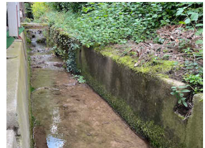
Abschnitt Leu_07; beidseitige Mauer, keine Breitenvariabilität (rund 15 m des Abschnittes)
